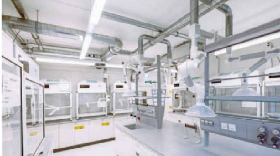
Die Reinraumbedingungen der Montanuniversität Leoben wurden unter anderem mit acht Laminar Flow Boxen des Herstellers Spetec realisiert.
