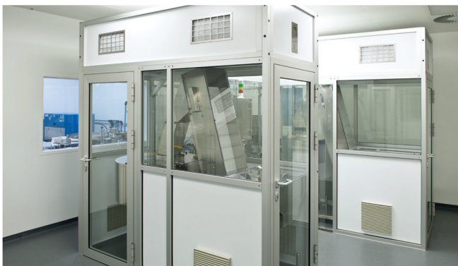
Reinraum Einhausung einer Maschine in der Pharmazie
